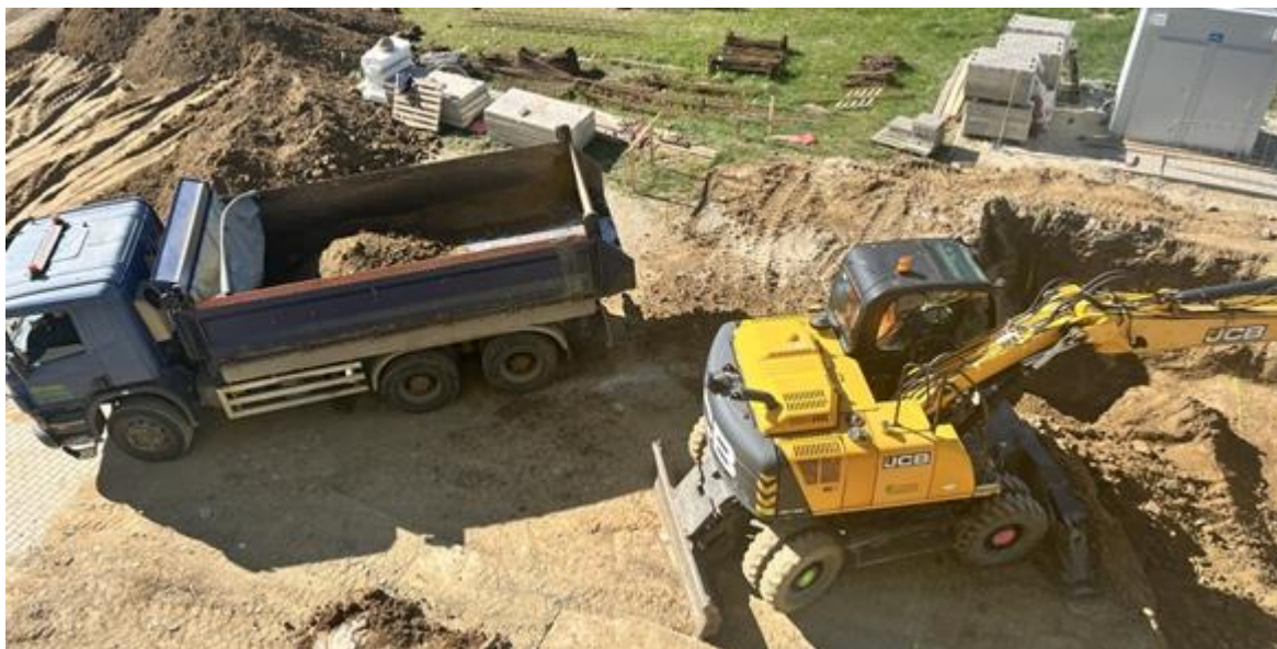
Obrázek 3: Zahájení přístavby budovy GD - zemní práce
